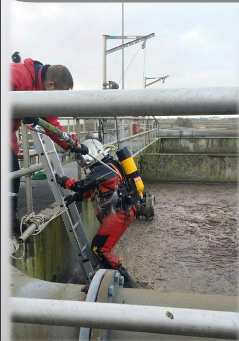
La tenue de plongée en milieu fortement contaminé et pollué, utilisé en circuit fermé. Le plongeur peut donc être complètement immergé.
